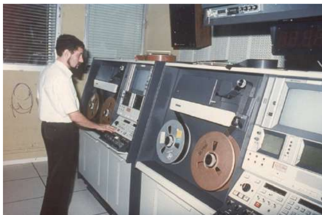
Figura 3. Sistema de grabación profesional Quadruplex AMPEX AVR3, 1975. Foto: Thurion, J.
